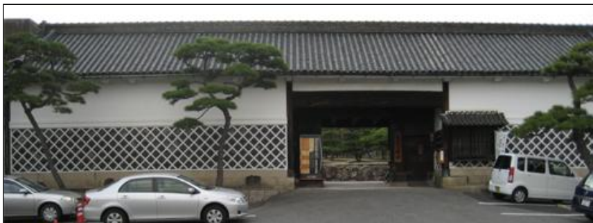
岡山城二の丸対面所跡に建長屋門 林原美術館
